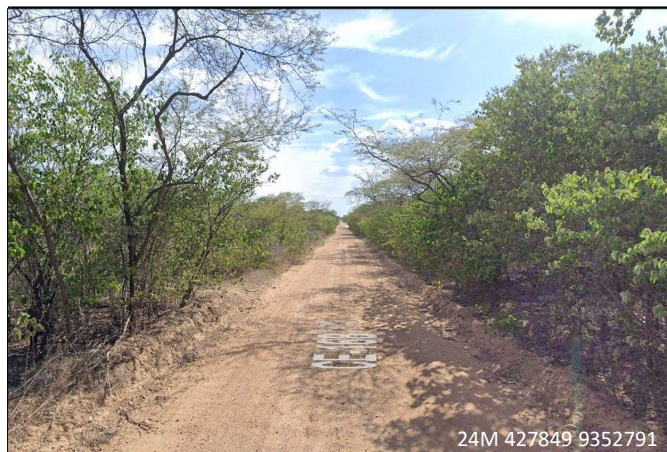
FIM DO PIÇARRAMENTO EST 445 + 0,00
